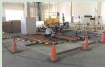
工事エリアの区画を設定して作業
