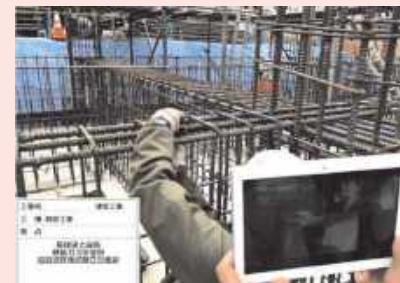
Webカメラを利用した遠隔検査
