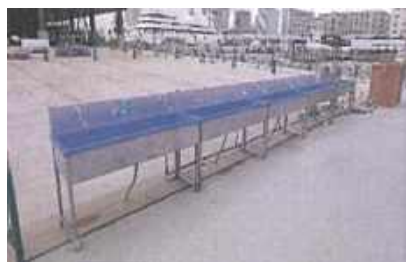
現場の手洗い場所の増設
