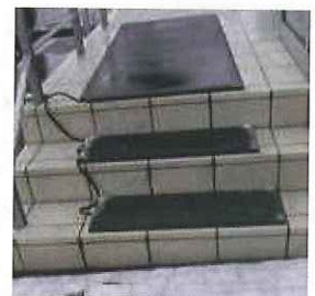
<ヒートマットの設置例>
